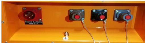
Raccordement 200 kW : 1 câble par phase + terre
