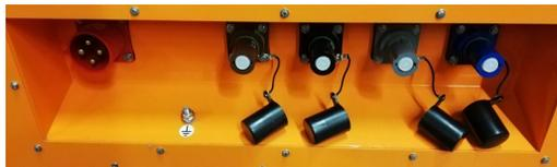
Raccordement 100 / 200 kW : 1 câble par phase + terre
